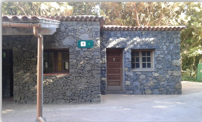
Foto superior: Fachada principal del Bar Restaurante La Laguna Grande. Foto inferior: Ampliación de aseos y vista parcial del nuevo porche.
